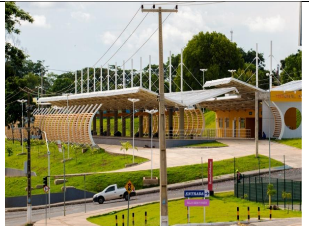
Foto 21: Terminal de integração do Bela Vista – em operação
