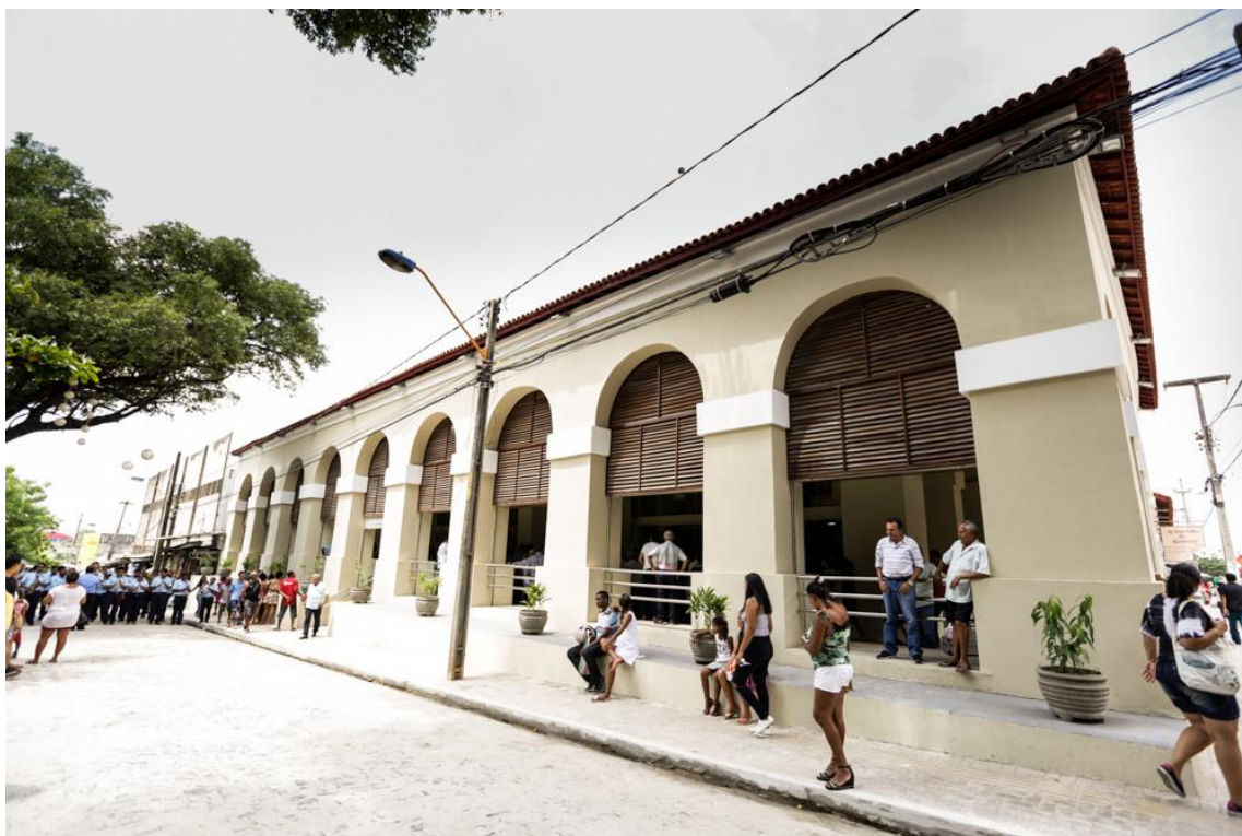
Foto 15: Fachada principal do Mercado São José, após a reforma da 1ª etapa.
