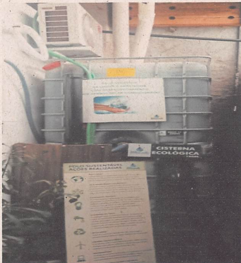
CISTERNA DE 2000L DE ÁGUA COLETADA DA CHUVA DO TELHADO DA EMPRESA POLO SUSTENTÁVEL E REUTILIZADA PARA IRRIGAÇÃO DO JARDIM E RESFRIAMENTO TÉRMICO DA EMPRESA.
