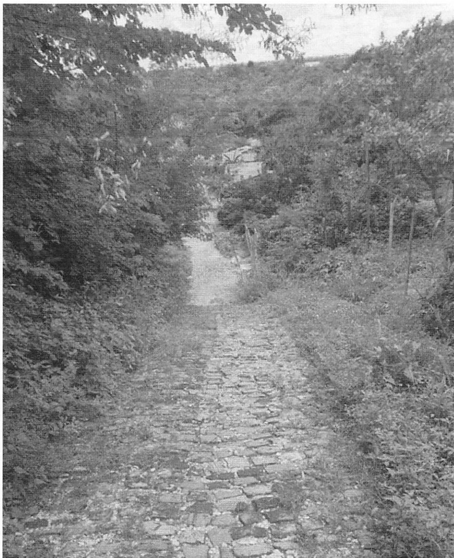
Figura 2: A via que se solicita a capina e limpeza situada no bairro Tabajaras, rua Chico Preto próximo ao colégio Alda Rodrigues Neiva se encontra com acúmulo de vegetação e resíduos que vem causando diversos transtornos a comunidade local.
