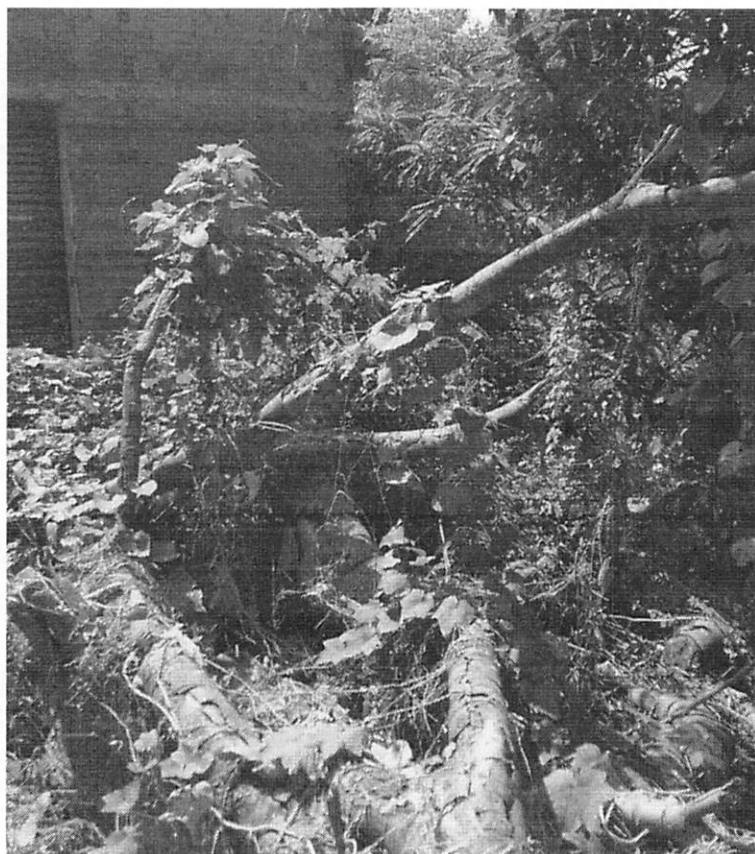
Figura 2: A falta de manutenção da via e o avanço descontrolado da vegetação têm gerado uma série de transtornos para os moradores, como o aumento de insetos e animais peçonhentos, risco de acidentes e o acúmulo de lixo entre os matos, afetando a saúde pública e o bem-estar da comunidade.
