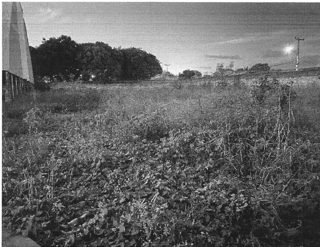
Figura 2: A alta vegetação e a escuridão na quadra da E. M Roberto Cerqueira Dantas representam riscos reais para alunos, servidores e moradores da comunidade. A falta de manutenção compromete a segurança e impossibilita o uso adequado do espaço.
