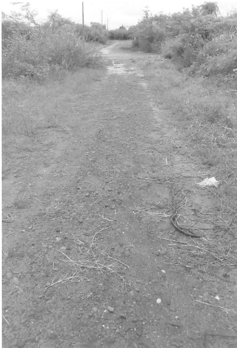
Figura 3: Além disso, o acúmulo de águas e vegetação no local tem prejudicado a mobilidade dos moradores e da população em geral, agravando ainda mais os impactos negativos enfrentados pela comunidade.
