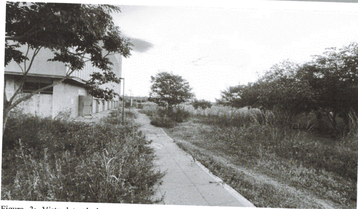
Figura 3: Vista lateral do entorno do Centro de Iniciação ao Esporte Estação Cidadania, demonstrando a necessidade de serviços de capina e limpeza da área.
