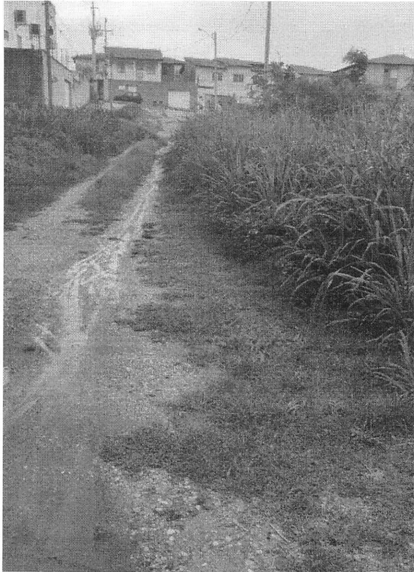
Figura 3: Via de acesso com vegetação avançando sobre o caminho e solo irregular, ocasionando transtornos no deslocamento e limitando o tráfego no local.
